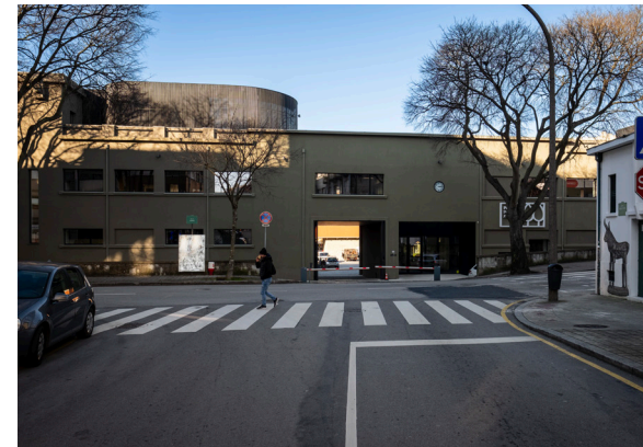
Edifício S. Dinis
