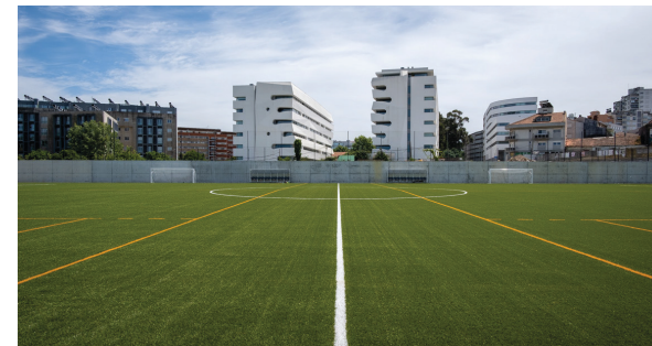
Construção do Campo do Outeiro - Instalações desportivas
