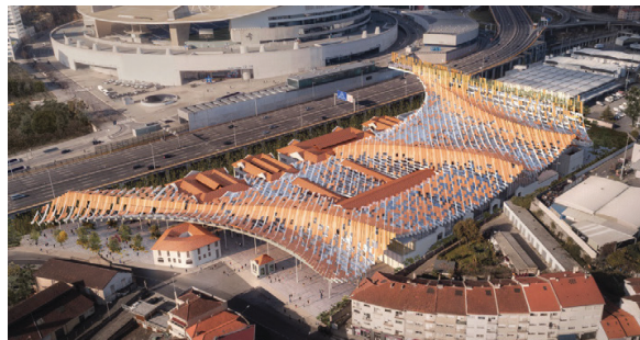
Reconversão do Antigo Matadouro Industrial do Porto
